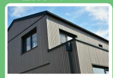
薄い金属が素材の軽量で水を通しずらい外壁です。
