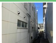
ALC(軽量気泡コンクリート)を 板状に形成したパネルです。 つなぎ 目が多い外壁です。
